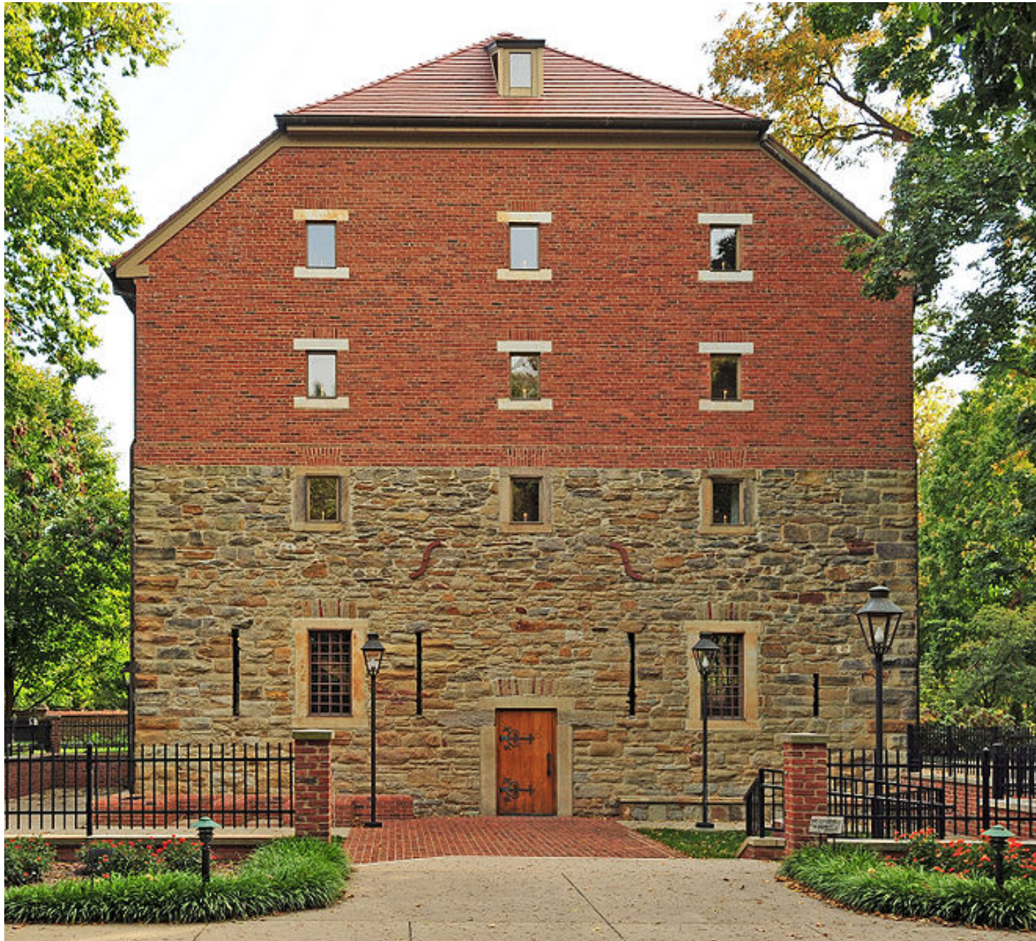
1818 von der Harmony Society erbaute Kornspeicher ist 1997-1999 restauriert worden. Er dient jetzt als Veranstaltungszentrum.
